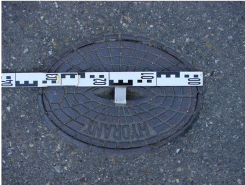
Straßenkappe eines Unterflurhydranten (Längsmaß)
