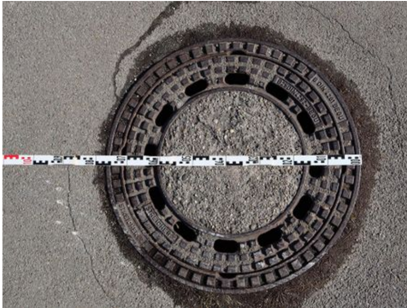
Schachtdeckel in Deutschland nach DIN 4291 mit einem sichtbaren Gesamtdurchmesser von ca. 77 cm
