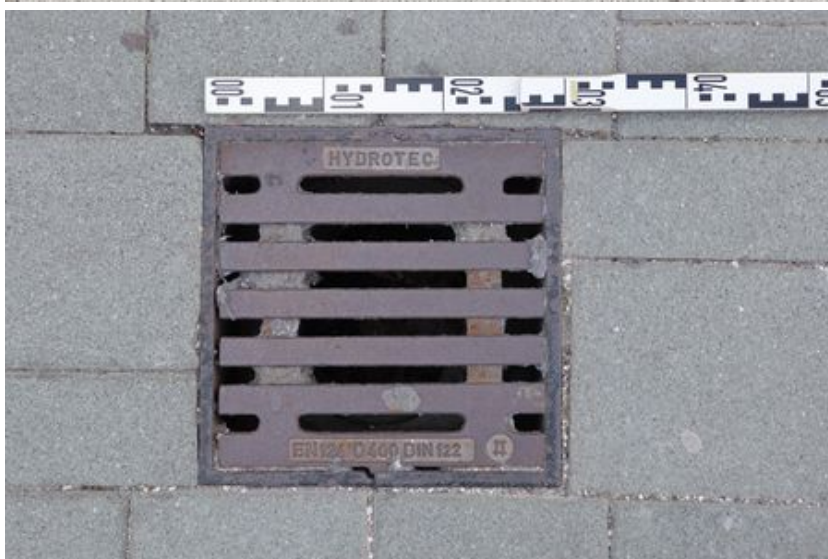
• Straßenablauf nach DIN 122 und EN 124, Lastklasse D400
